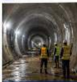
TÚNELES Y OBRAS SUBTERRÁNEAS
